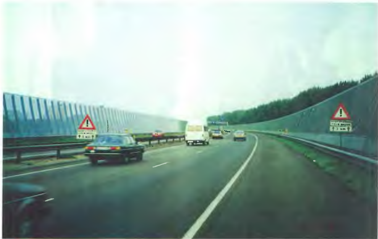
Рис. 2—5. Конструкции и варианты размещения шумозащитных экранов вдоль автомагистралей (данные НИИ Строительной физики)
